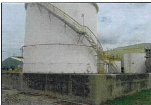
ภาพที่ 2.2-19 ถังเก็บสารเคมี และคันคอนกรีตรองรับภาวะการรั่วไหล
