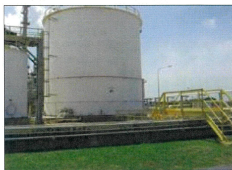
ภาพที่ 2.2-19 ถังเก็บสารเคมี และคันคอนกรีตรองรับภาวะการรั่วไหล
